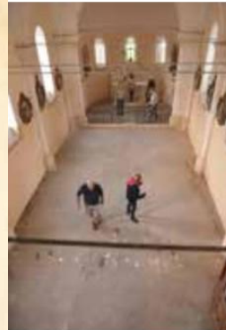
Nettoyage avant travaux
